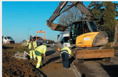
Création des trottoirs. Route de Vacquiers RD30.
