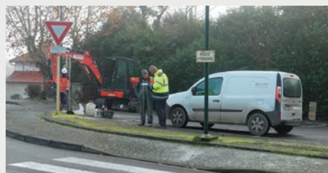
Remise en service de la fontaine et installation de 2 portiques pivotants.
