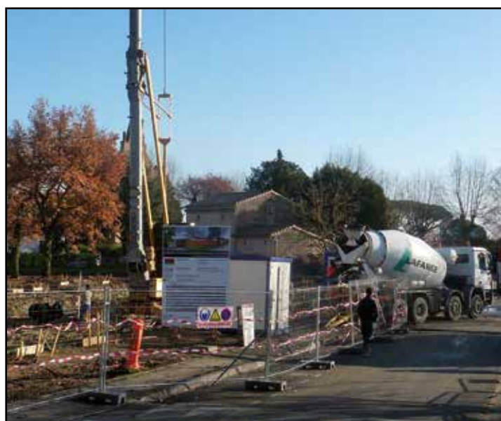
Création des fondations
