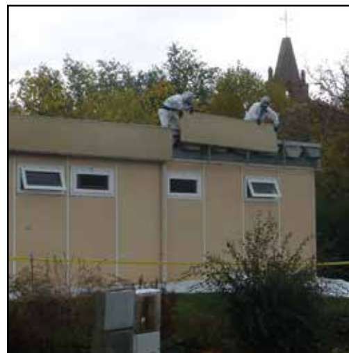
Désamiantage de la cantine
