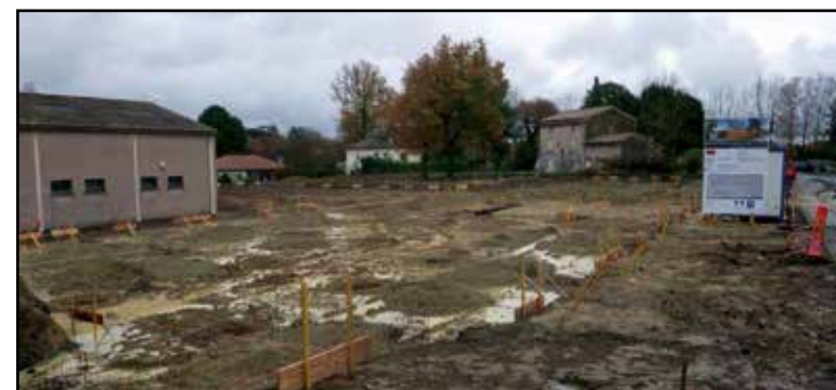
Terrassement du terrain
